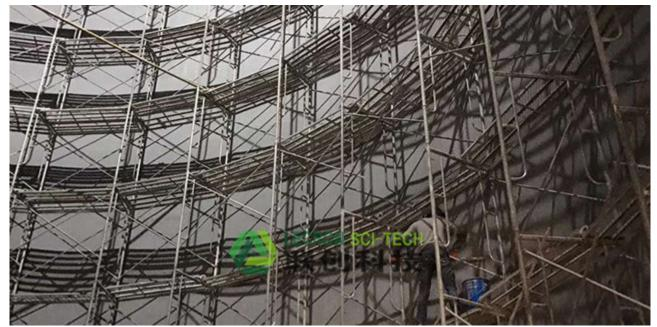
在进行一项大的工程前,联创科技都要做一些列准备工作,准备工作是正是正式施工的前提,把该准备的材料、工具都弄好,还有施工前有些步骤是需要我们提前做好的,这也需要我们来做,下面是我们聚脲防水涂料施工前的准备工作说明。 聚脲喷涂前在混凝土上使用专门的封闭底漆,封闭底漆的作用主要有两个:一是封闭混凝土底材表面毛细孔中的空气和水分,避免聚脲喷涂后涂层出现鼓泡和现象;二是封闭底漆可以起到胶黏剂的作用,提高聚脲涂层与混凝土底材的附着力,提高防护效果。此工程采用低粘度的固含量的环氧类涂料作为封闭底漆,保证其渗透性。 准备工作如果没有弄好的话,那么我们聚脲防水涂料施工的时候可能就显得手忙脚乱,那样一来,我们的施工进程也会大受影响,把该做的事情提前做好,那样的话,我们会省很多事情。
