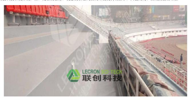
根据联创科技介绍聚脲不含催化剂,快速固化,可在任意曲面、斜面及垂直上喷涂成型,不产生流挂现象,5秒钟凝胶,1分钟即可达到步行强度。对湿气、温度不敏感,施工时不受环境温度、湿度的影响(可在-28℃下施工;可在冰面上喷涂固化)。双组分,固含量,不含任何挥发性有机物□VOC□□对环境友好,施工,卫生施工使用。1、热喷涂或浇注,一次施工厚度范围可从数百微米到数厘米,克服了以往多次施工。2、优异的理化性能,极高的抗张抗冲击强度、柔韧性、耐磨性、防湿滑、耐老化、防腐蚀。3、具有良好的热稳定性,可在120℃下长期使用,可承受350℃的短时热冲击。4、原形再现性好,涂层连续、致密,无接缝,无针眼,美观实用耐久。5、使用成套设备施工,效率极高;一次施工即可达到设计厚度要求,设备配有多种切换模式,既可喷涂,也可浇佳。并可通过施工工艺控制接达到防滑效果。6、具有良好的粘结力,可在钢材、木材、混凝土等任何底材上喷涂成型。聚脲厂家在大家施工的时候在包装上都会附上一份说明,这样大家可以的了解和使用
